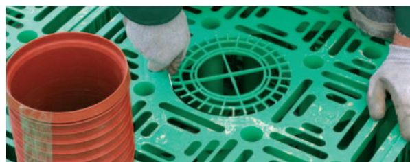
Geotextilie, na ní dna boxů a dvě vrstvy boxů
