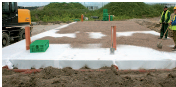
Příklad odvětrání (zde KG trubky DN 200)
