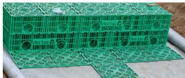
Geotextilie, na ní dna boxů a dvě vrstvy boxů
