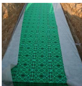
Po ovinutí geotextilií
