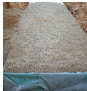
První vrstva zásypu
